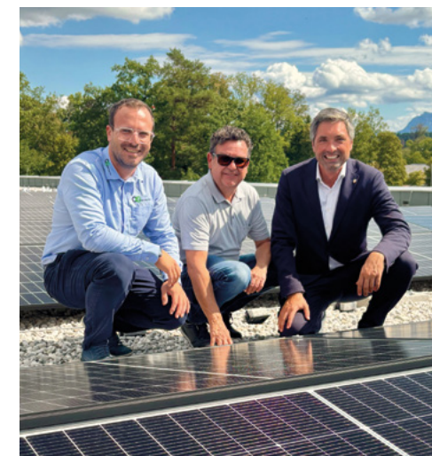
Bernhard Kalleitner, Geschäftsführer und Gesellschafter der Firma Oberndorfer, Finanz- und Energiestadtrat Stefan Maier und Bürgermeister Peter Schobesberger auf dem Dach des neuen Feuerwehrhauses in Vöcklabruck
