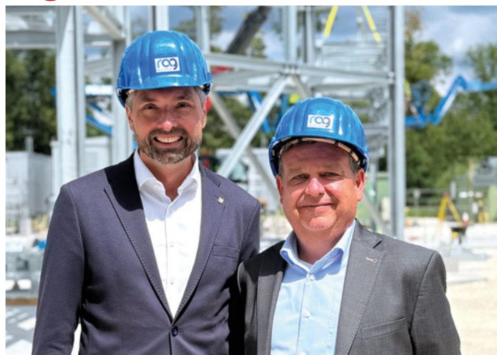
Vizebürgermeister Stefan Maier und Bürgermeister Peter Schobesberger auf der Großbaustelle der Elektrolyseanlage der RAG Austria
