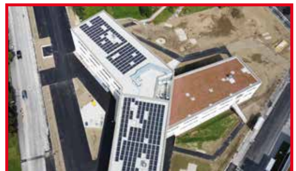
PV - Anlage auf dem neuen Bildungscampus
